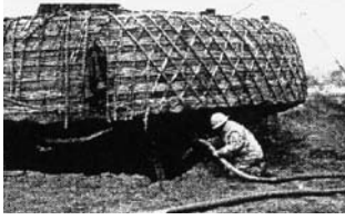
⑪土工 改良土埋め戻し・酸素管設置ほか
