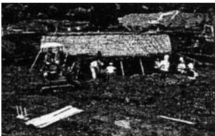
④土工 2,3次掘削・ベイジリ部人力掘削
