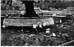
③土工 1次掘削・根巻下巻・土留め矢板
