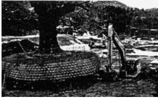
⑫土工 発生土埋め戻し・排水管設置ほか
