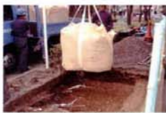
歩道下の路床に入った根を掘り出し、根系誘導耐圧基盤を投入し、タンバ等で転圧する
