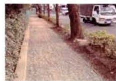
埋め戻した後、舗装する
