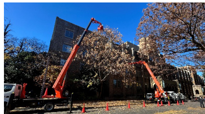
写真4 屈曲式ブーム型を備えた高所作業車状況 ©T.NOMURA
