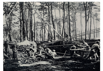
明治神宮内苑造成時における樹木の立曳きの様子 出典：上原敬二『樹木根廻運搬並移植法』
