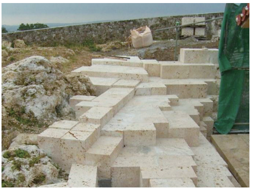
中庭に切石を設置
