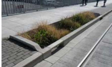
歩道に沿った雨水浸透型の植栽帯
