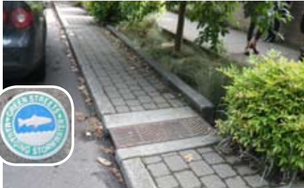
初期に整備された歩道に沿った雨水浸透型の植栽帯と認定サイン
