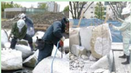
石材加工④と石垣天端石の施工状況
