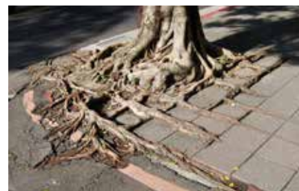
ガジュマルの水平根が歩道平板の目地に沿って伸長している様子
