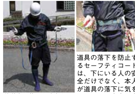
移動中の落下を防止する安全帯ランヤードの2丁掛
