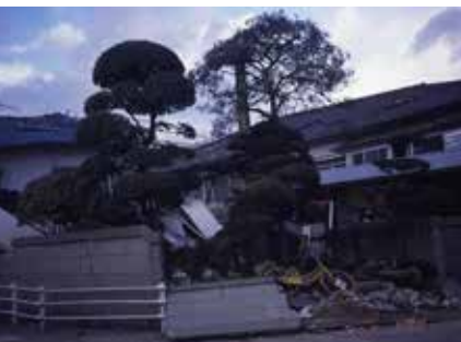
写真3 倒壊したブロック塀（阪神・淡路大震災）
