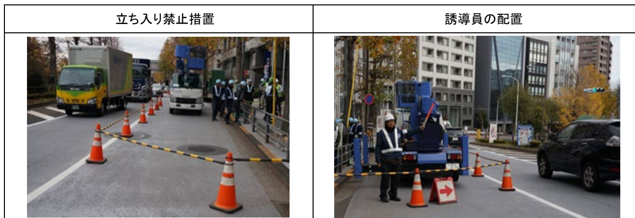
図 3-3 高所作業車使用時の安全対策
