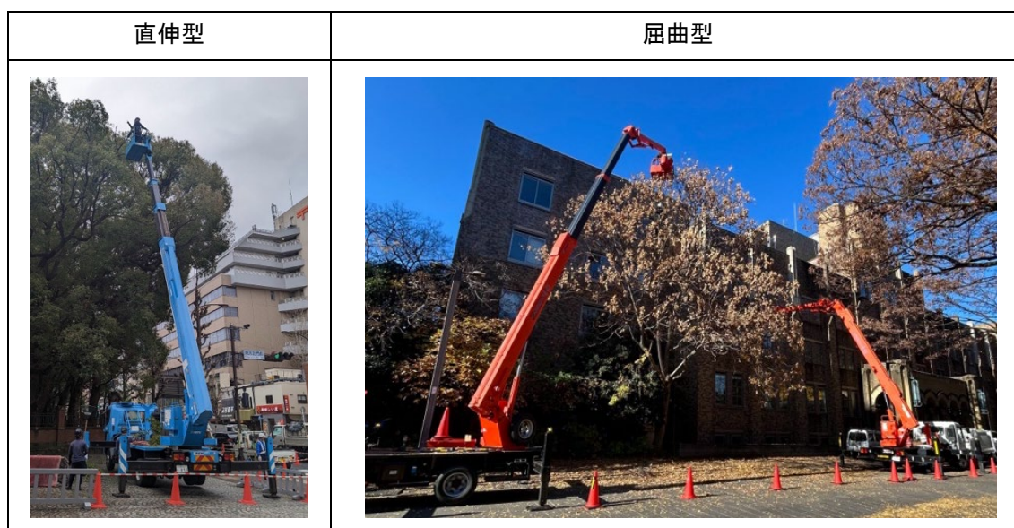
図 3-1 高所作業車による剪定のイメージ
